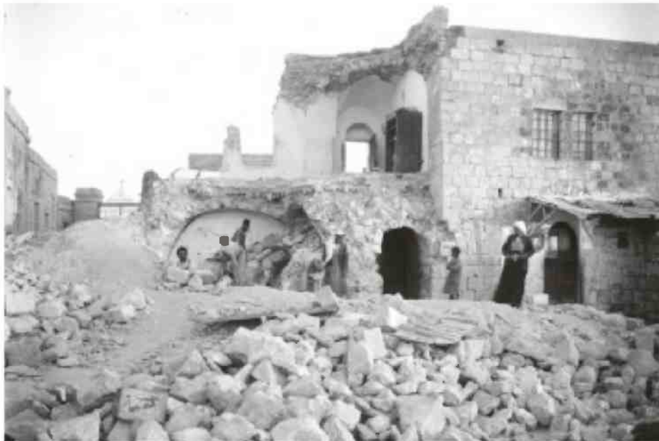
הריסות בהר הזיתים, לאחר רעידת האדמה הקשה ב-1927 צילום: צלמי המושבה האמריקאית/אוסף ספריית הקונגרס
